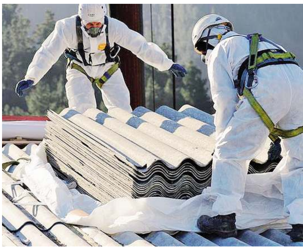
Tecnici specializzati lavorano ad un intervento di rimozione di una copertura in amianto
